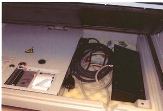
Opbergen kabels en bedieningspaneel
